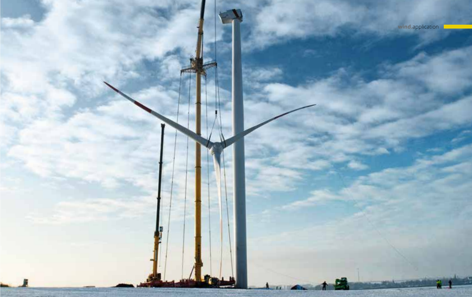
▲ Errichtung einer e.n.o. energy Windenergieanlage in Sachsen-Anhalt
