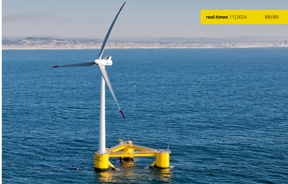
Die 2 MW-Turbine des Projekts „WindFloat“ (EDP Renewables) wurde bereits 2011 installiert.
