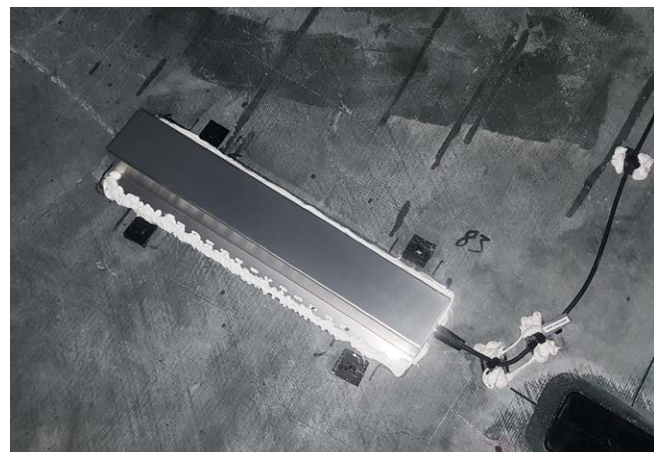
Serientaugliche, rasche Installation: Die Cantilever-Sensoren CLS300 werden als vorausgerichtete Sensoreinheit auf einer Montageschiene geliefert und einfach aufgeklebt.
