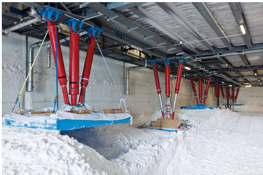
Die vom Alfred-Wegener-Institut betriebene Neumayer-Station III wird von 16 Stelzen getragen. Regelmäßig heben Techniker die Station mit einer hydraulischen Hebevorrichtung an, um den jährlichen Schneezutrag von etwa einem Meter auszugleichen.
