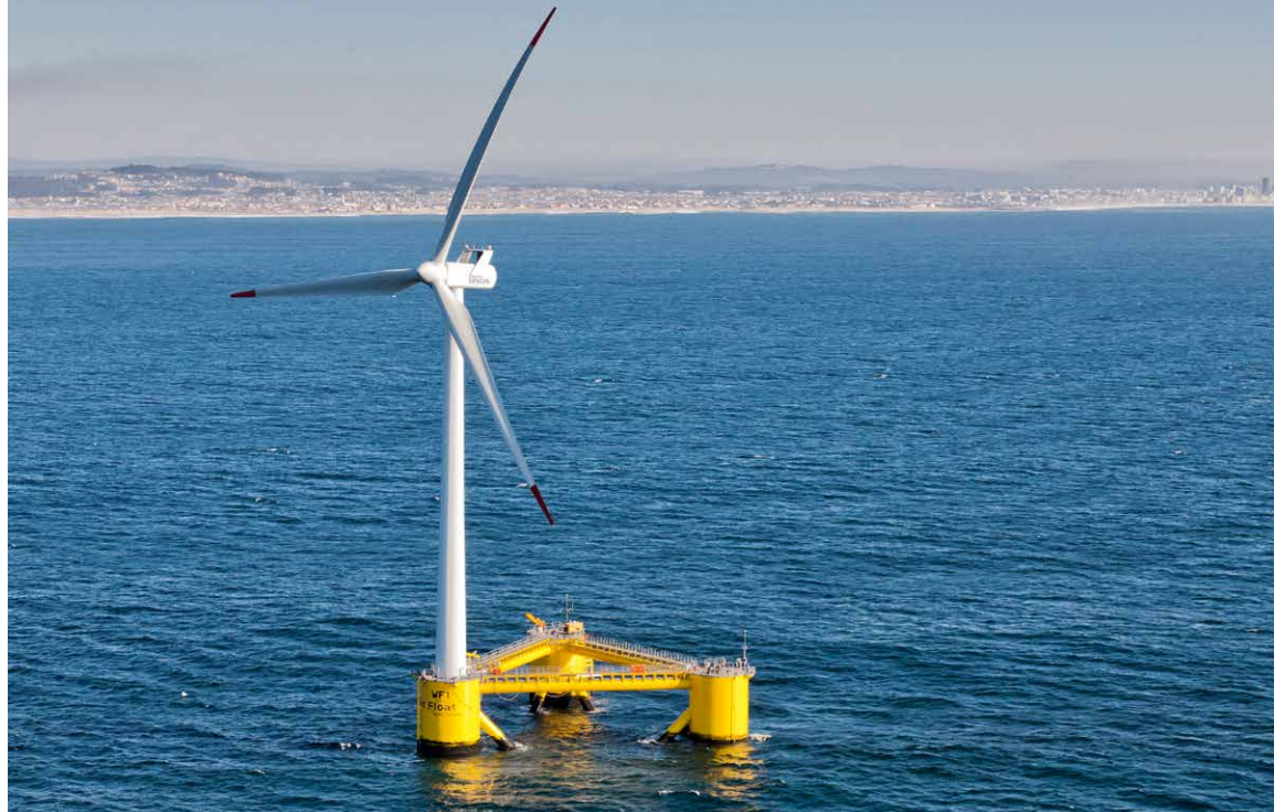
Die 2 MW-Turbine des Projekts „WindFloat“ (EDP Renewables) wurde bereits 2011 installiert. Sie ist als „Halbtaucher“ etwa 5 km vor der Küste von Agucadoura, Portugal, installiert.
