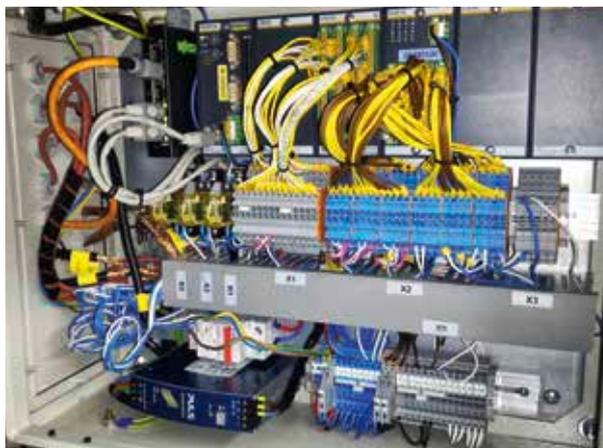
► Kompakte Lösung: Der FEC wird innerhalb des Maschinenraums installiert und minimiert so die Verkabelung bei Nachrüstungen.
