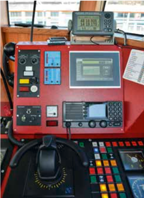
▲ Das neue OT Panel, integriert im Steuerhaus
