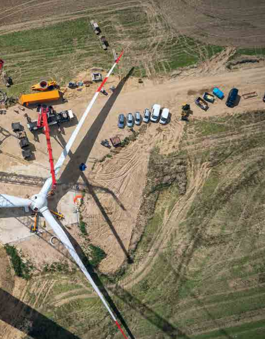
▲ Errichtung des ersten Prototyps der P3000 im Windpark Krackow-Glasow.
